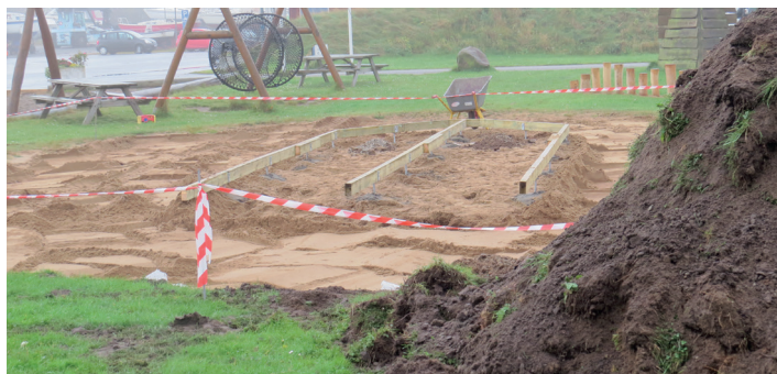
Fundamentet er lagt på støbte betonklodser
